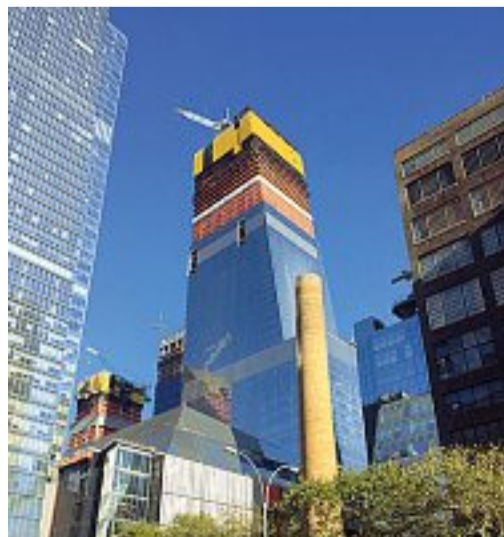
Lo skyline (in costruzione) del West Village
